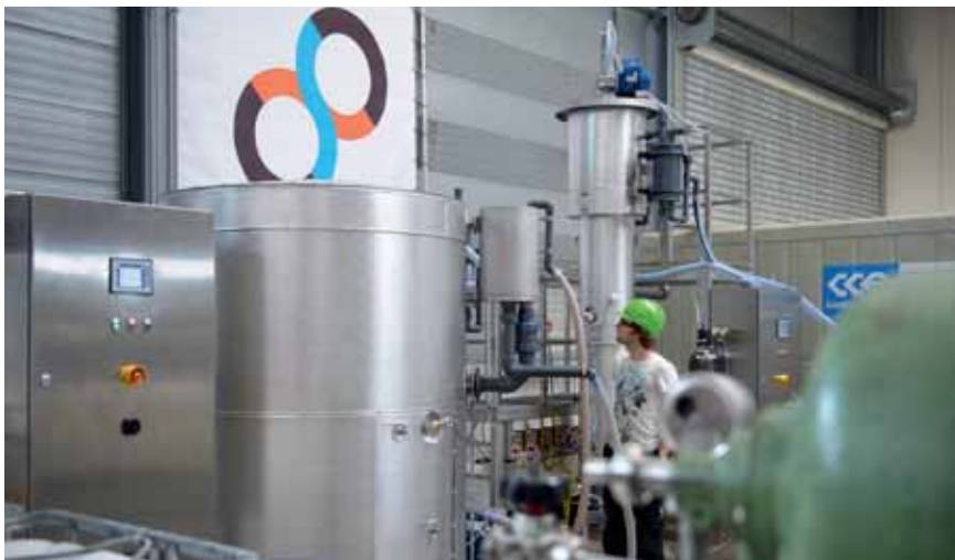
De pilotinstallatie wordt vervangen door een demonstratiefabriek die 10.000 ton voedselresten per jaar kan verwerken.
